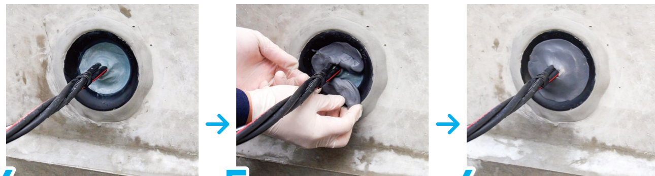
4 ミズストッパー施工完了
